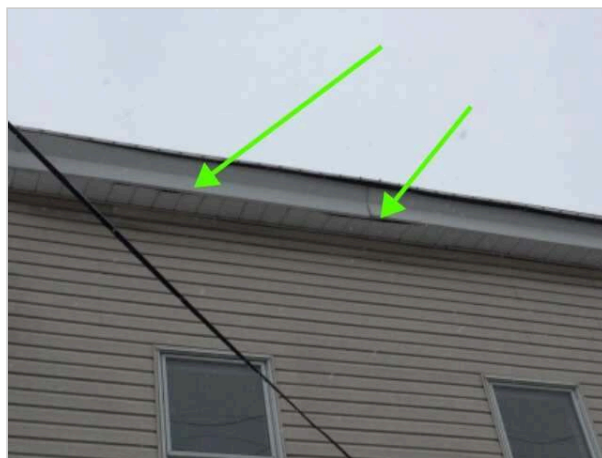
Loose soffit.
