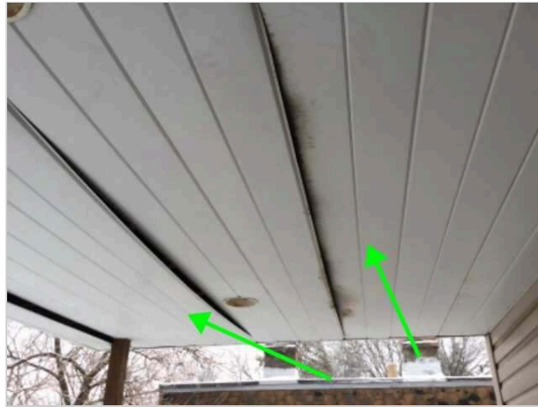
Loose soffit
